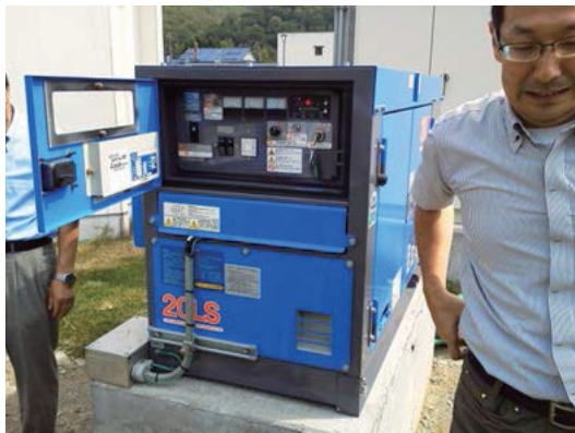
(写真3) 非常用電源バッテリー
