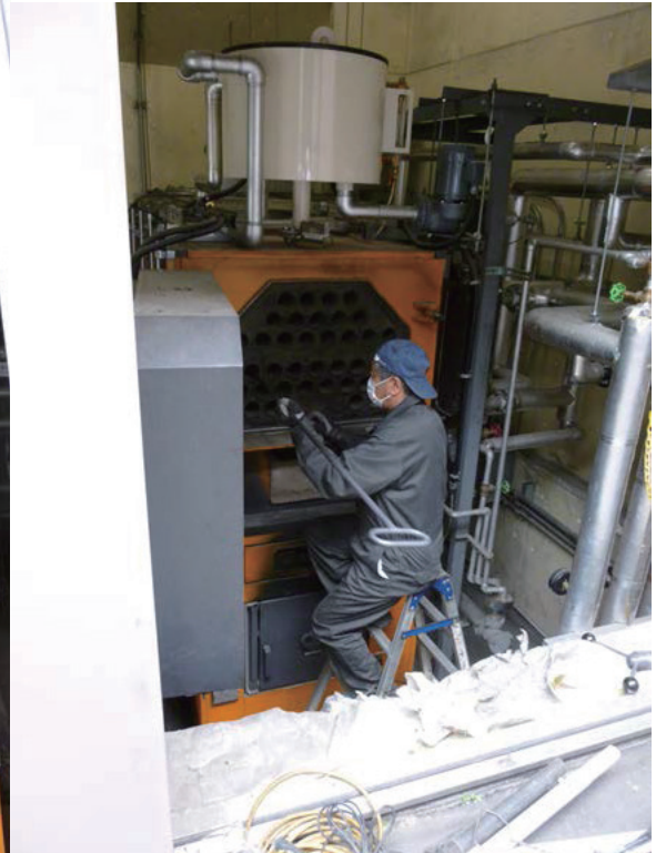
(写真2) 内部の清掃の様子
