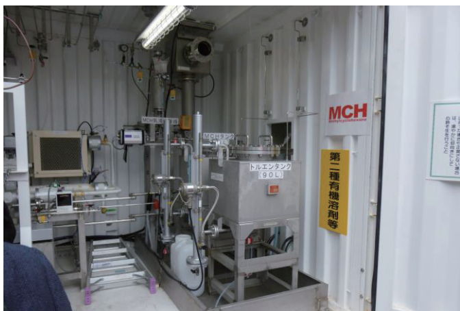
写真 3：水素圧縮コンテナ 右はトルエンタンク
