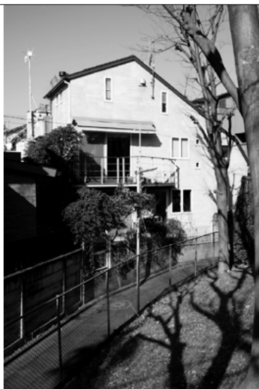
羽根木エコハウス全景
